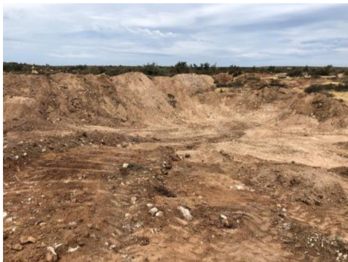
Vista del sector central del Desmonte.
