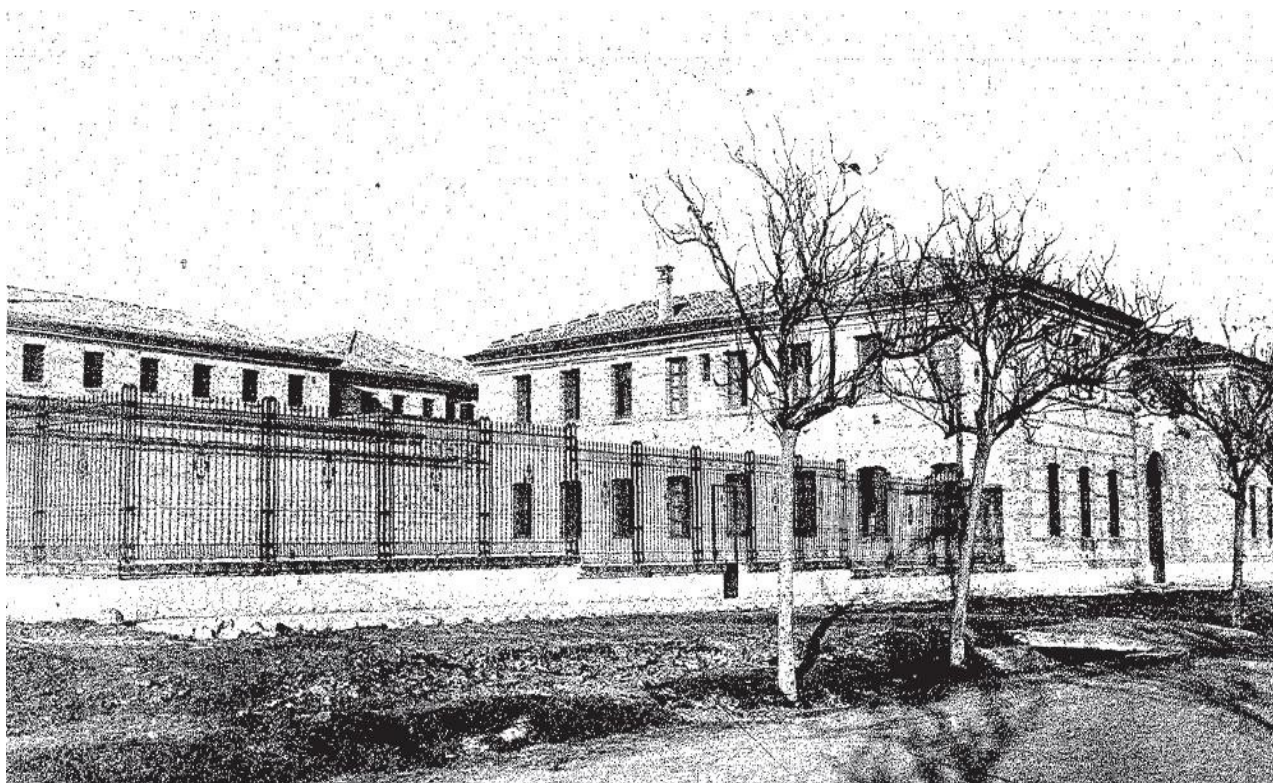
Fotografía 5: Fachada de la nueva Prisión provincial de Málaga. Foto que ilustra el reportaje titulado: "Fortaleza de la justicia y sanatorio de las almas" 1934
