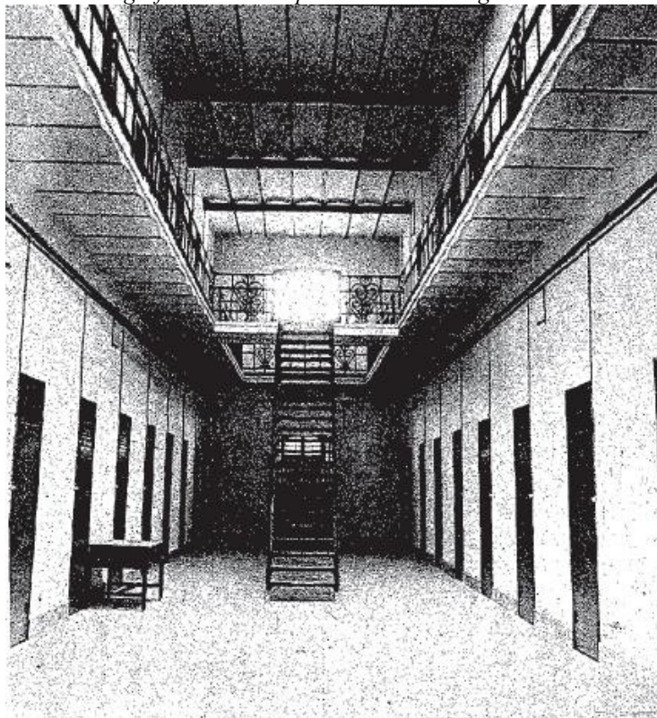
Fotografía 7: Prisión provincial de Málaga. Galería
