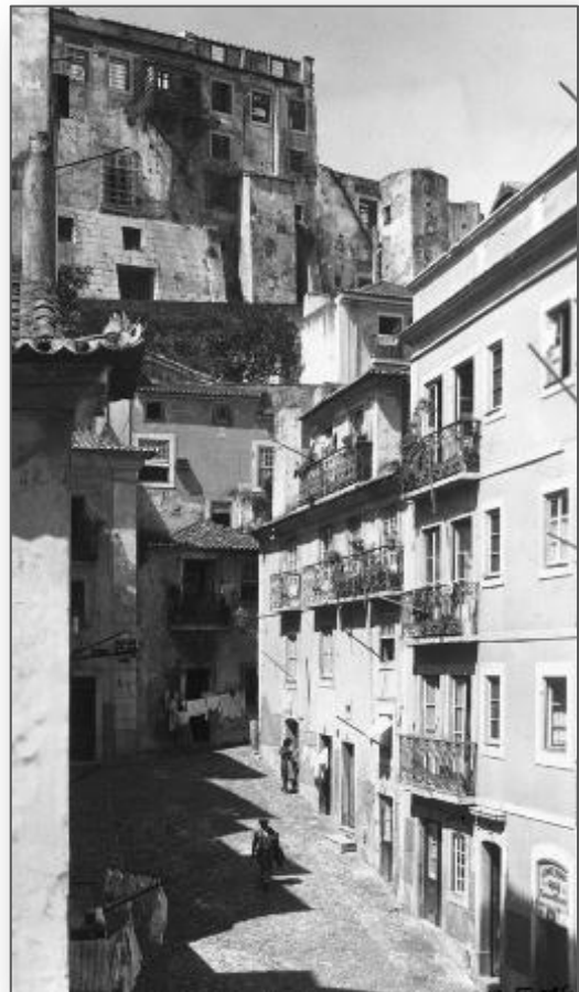
Imagem 21 – Fachada da Cadeia do Limoeiro vista da Rua da Adiça – Fotografia de Eduardo Portugal. Segundo um Relatório de 1939, foram apontadas fendas em diversos locais, fraturas de cantarias, desaprumos de paredes, e estabilidade precária. O edifício, para além de estar inclinado 15 cm para o casario de Alfama, poderia ruir numa eventualidade de tremor de terra ou de chuvas fortes. Nesse sentido, em 1941, foi ordenada a demolição deste corpo, até ao nível do coroamento da muralha virada para Alfama.
