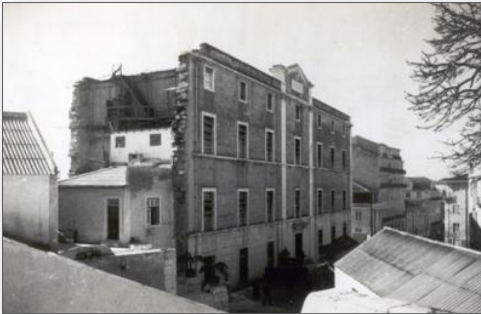
Imagem 16 – Obras realizadas em 1948 na Cadeia do Limoeiro pelos reclusos das Cadeias Civas Centrais de Lisboa
