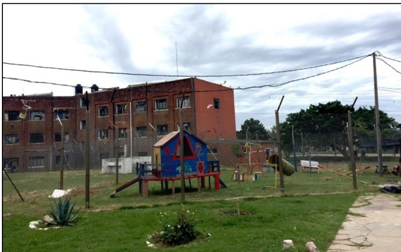
Imagen 4. Edificio celdario visto desde las oficinas de la administración
