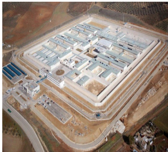
Foto: Centro Penitenciario de Archidona., en construcción
