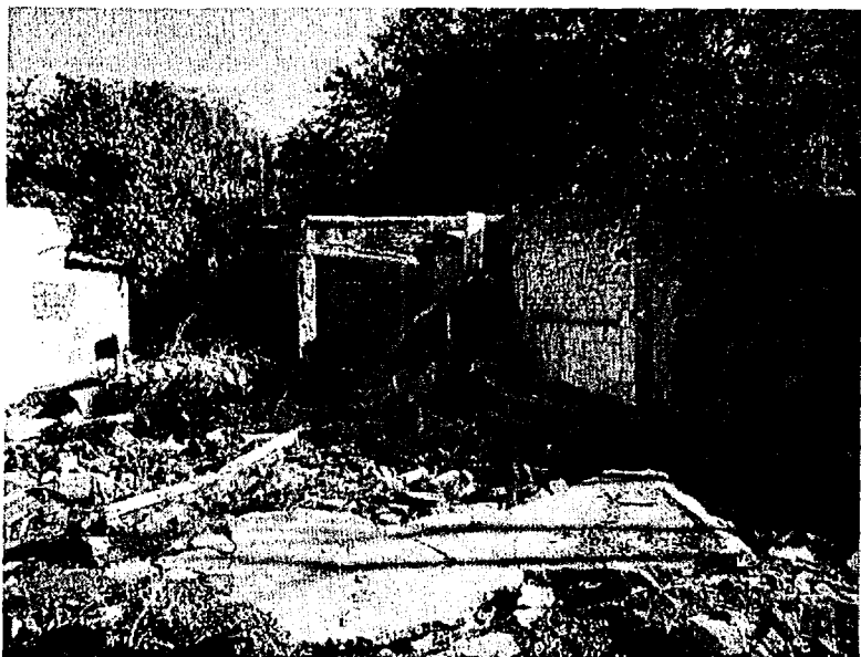
Foto 6. Escombros y ladrillos de lo que fue una vivienda de una familia trasladada a Ciudad de Mis Sueños. A pocos metros se encuentra ubicada la vivienda de Doña Chichona.
