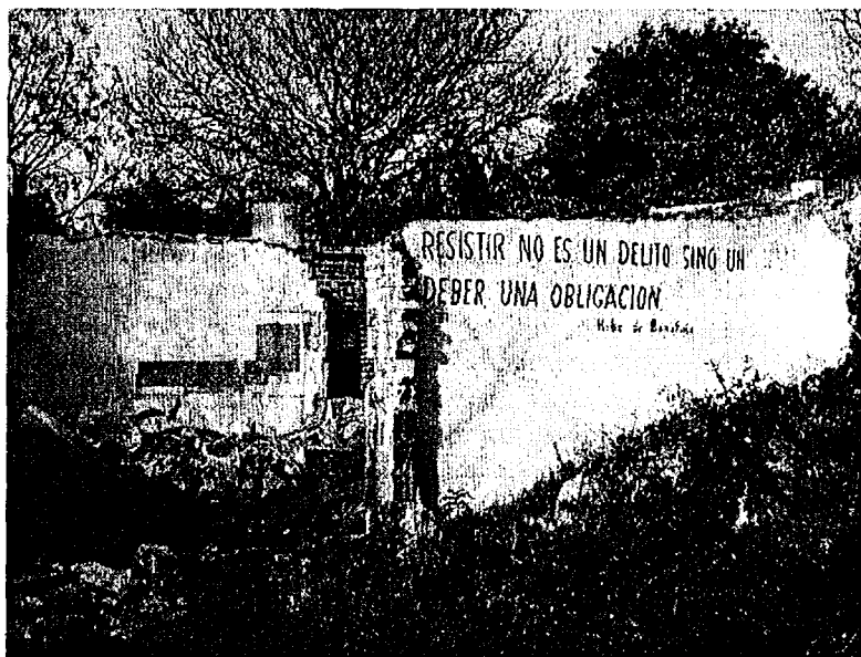
Foto 2. De la casa colindante de uno de nuestros entrevistados sólo quedaron las paredes medianeras. (Mayo de 2006).
