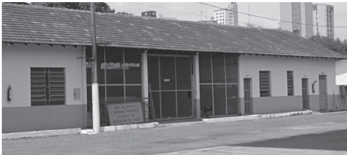
Via interna, em alvine, com acesso ao pátio do pelotão de manutenção e transporte do quartel do 12º Regimento de Infantaria do Exército, em Belo Horizonte, reconhecido por ex-presos políticos como local onde foi praticada tortura. Fonte: Arquivo CNV
