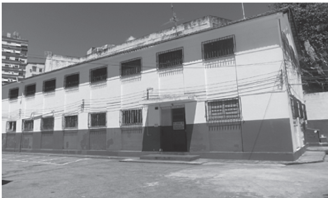
Edificação onde atualmente funciona o PIC. Fonte: Arquivo CNV
