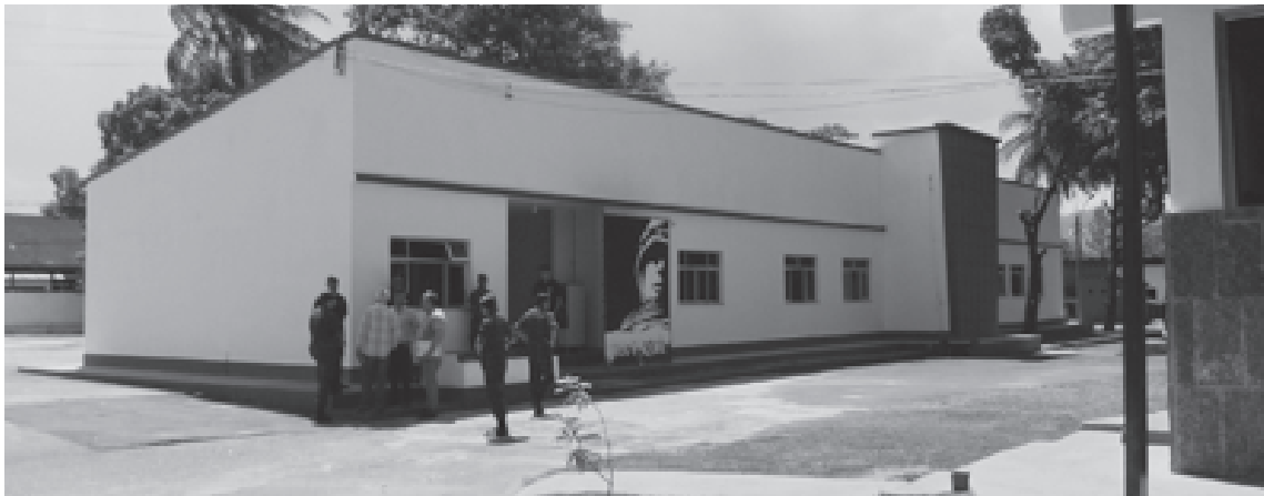
Parte anterior do prédio. Fonte: Arquivo CNV
