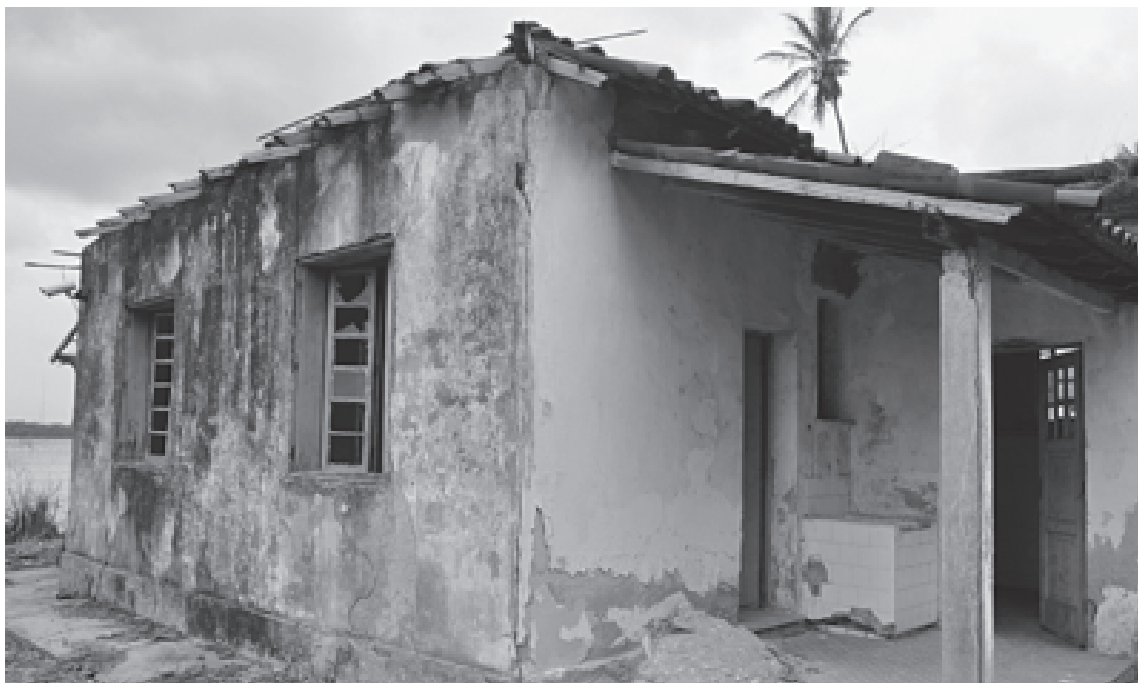
Lateral direita da edificação. Fonte: Arquivo CNV
