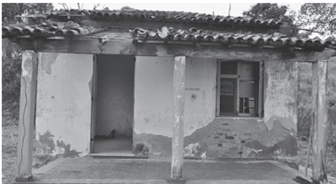
Vista frontal da edificação. Fonte: Arquivo CNV
