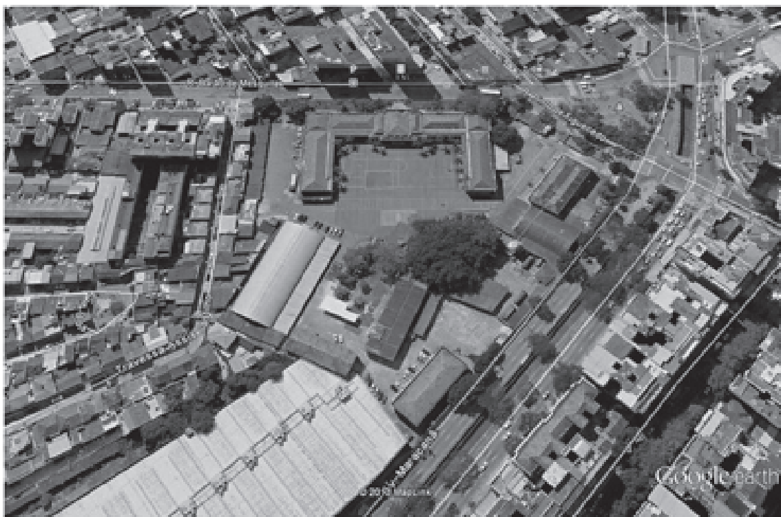
Vista aérea do 1º Batalhão de Polícia do Exército, com destaque para o prédio onde funcionava o Pelotão de Investigações Criminais (PIC). Fonte: Google Earth
